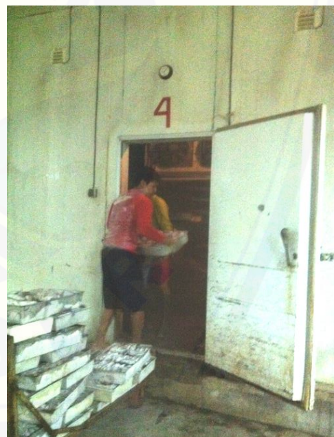
Gambar 4. Ruangan pembekuan ikan Air Blast Freezing dengan suhu -40^{\circ}\text{C}
