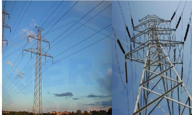
Gambar 2.1 dan 2.2 Menara atau tiang transmisi.
