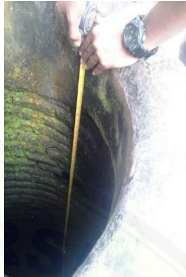
Gambar 2. Pengukuran Kedalaman dinding sumur
