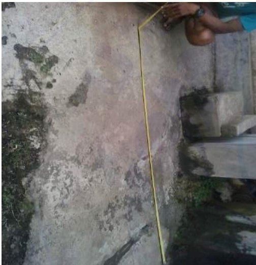
Gambar 9. Pengukuran lebar lantai sumur gali
