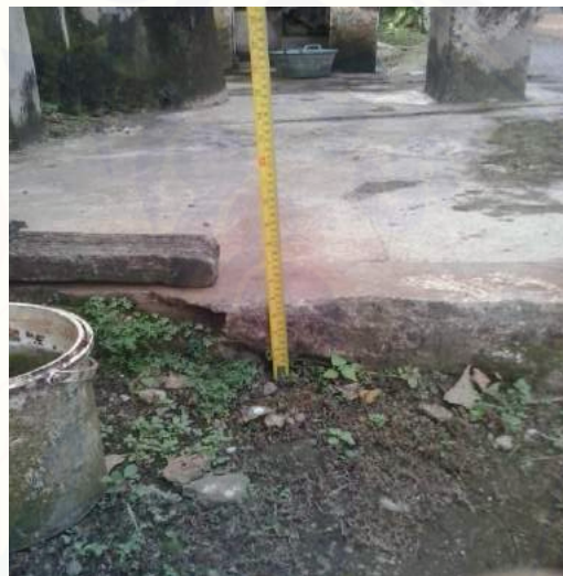
Gambar 10. Pengukuran tinggi lantai sumur gali
