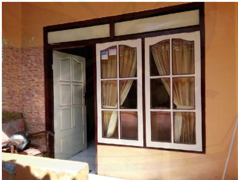
Gambar 12. Kondisi rumah dari pensiunan 1 berinisial BS
