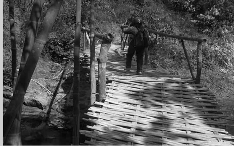
Gambar 27. Jembatan bambu akses jalan menuju bendungan.
