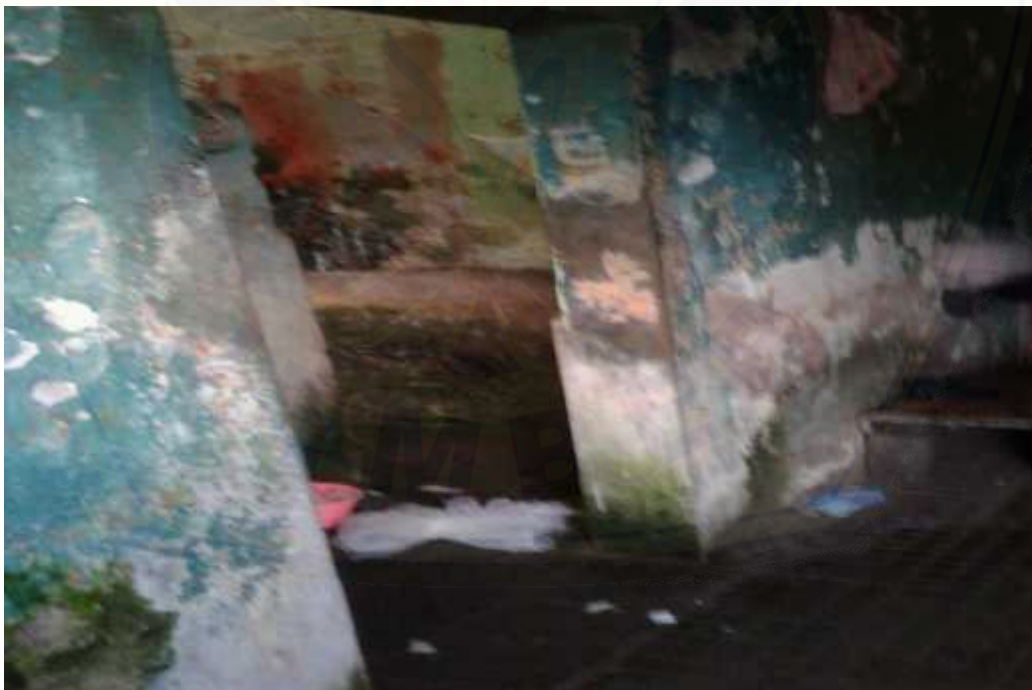
Gambar 4. Kamar Mandi dan Jeding Tampak Luar
