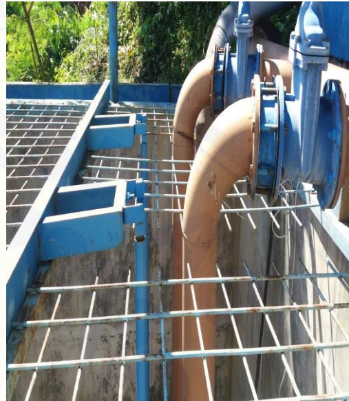
Bangunan penangkap dan penampung air ( intake )
