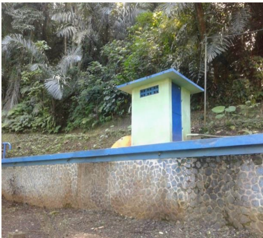
Broncap (bangunan penangkap sumber air)
