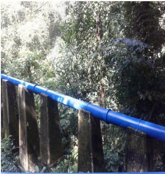
Pipa saluran distribusi air bersih
