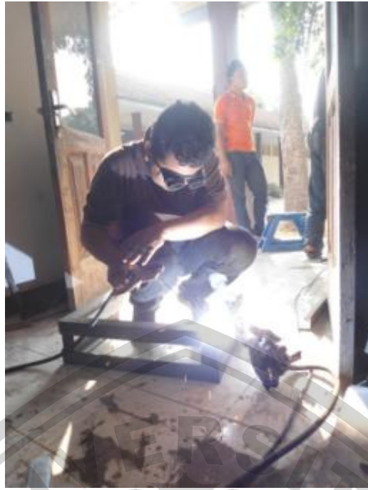
Gambar 15. Proses pembuatan alat blow molding plastik
