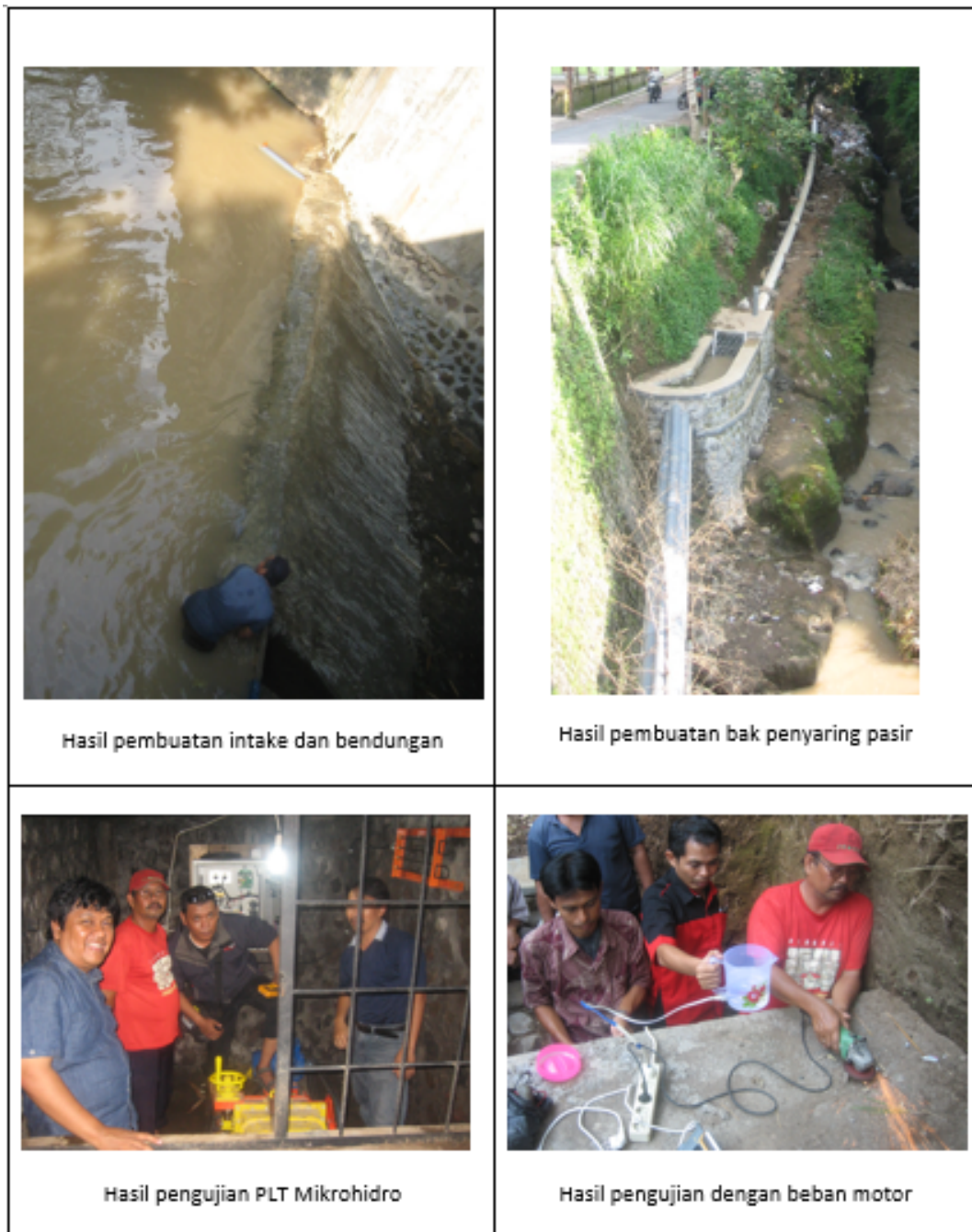
Gambar 2 Pembangunan PLTMH Suger
