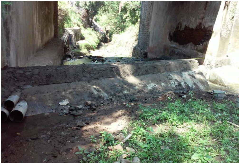
Gambar 6. Penyemenan kasar pada bendungan
