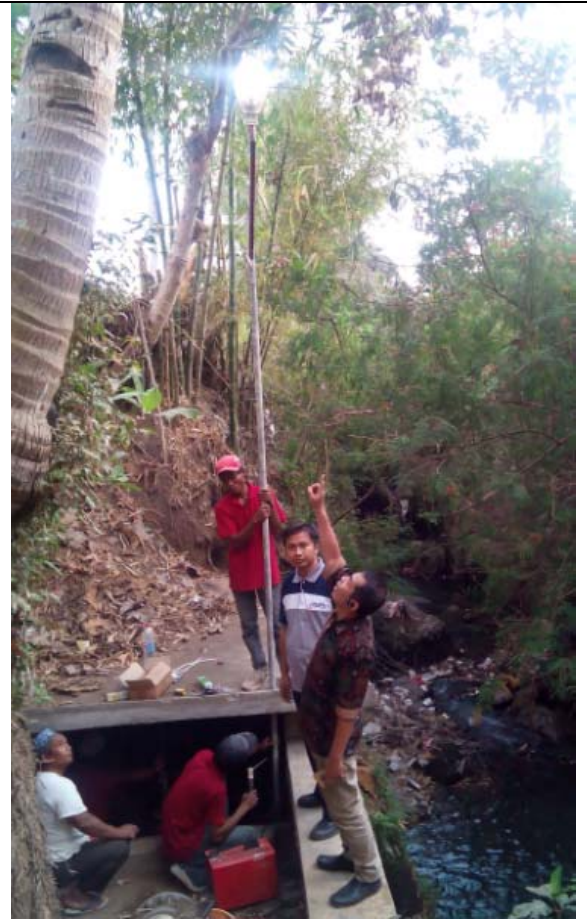
Gambar 11. Pemasangan instalasi lampu penerangan
