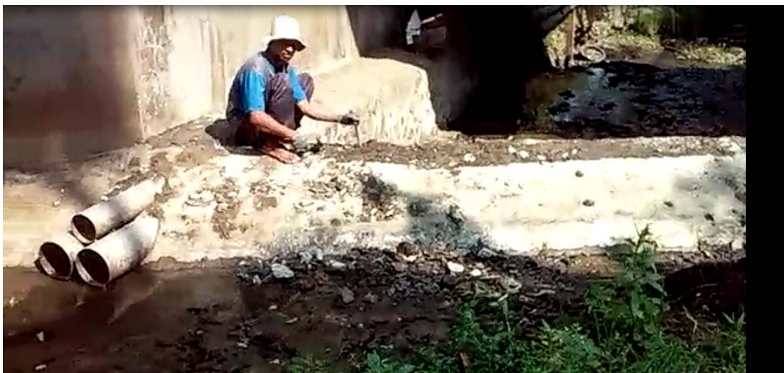
Gambar 4. Pembongkaran bagian atas bendungan
