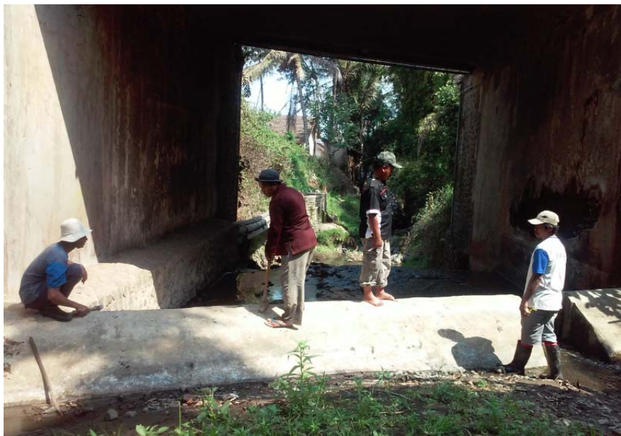
Gambar 4. Persiapan pembongkaran bagian atas bendungan
