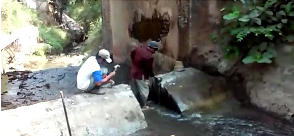
Gambar 4. Pembongkaran bagian atas bendungan
