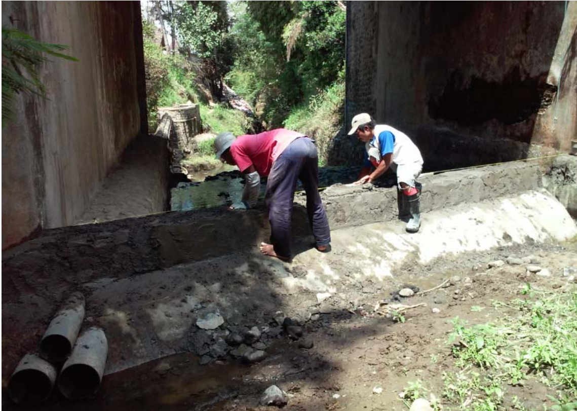
Gambar 6. Penyemenan kasar pada bendungan
