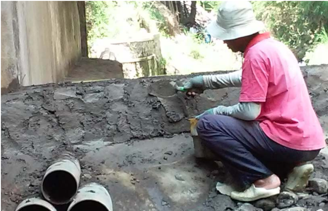
Gambar 6. Penyemenan kasar pada bendungan
