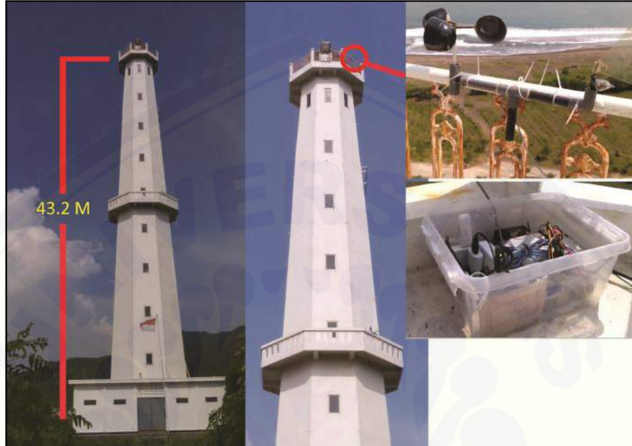
Gambar F.1 Tempat pemasangan alat monitoring sebagai objek penelitian
