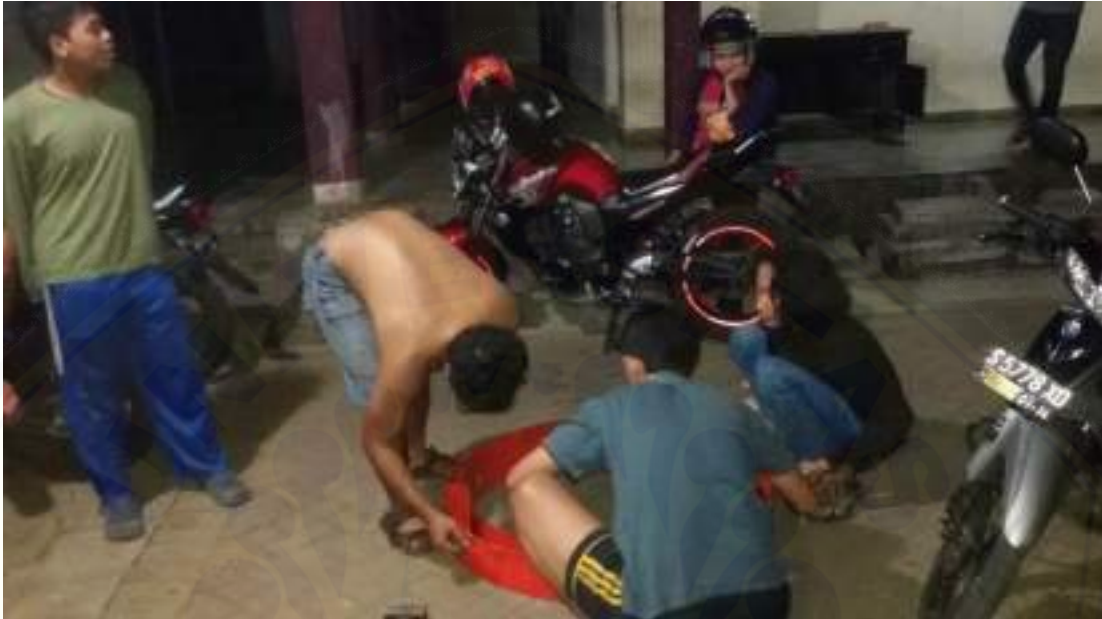
Proses Fabrikasi Bekisting Benda Uji Balok Lengkung
