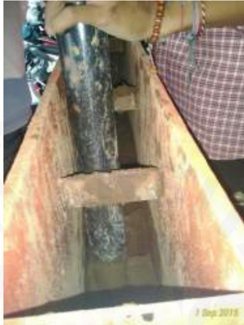
Proses Pemasatan Tanah
