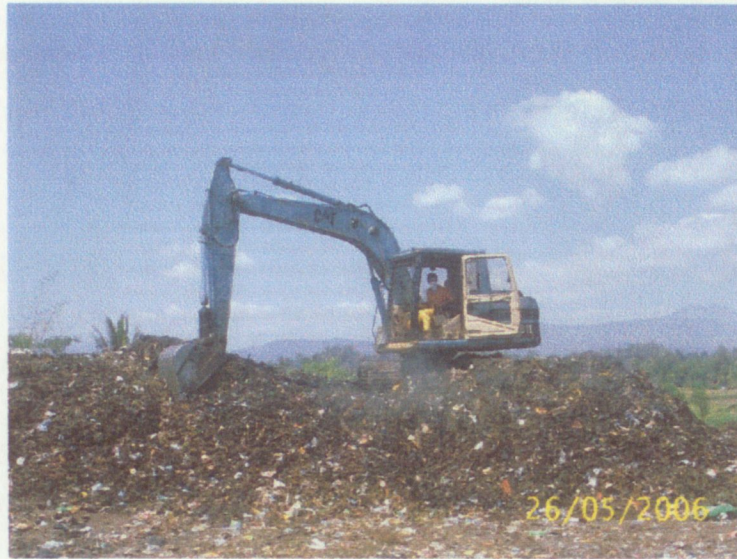
Pemerataan dan pemadatan sampah dengan menggunakan excavator di TPA Pakusari
