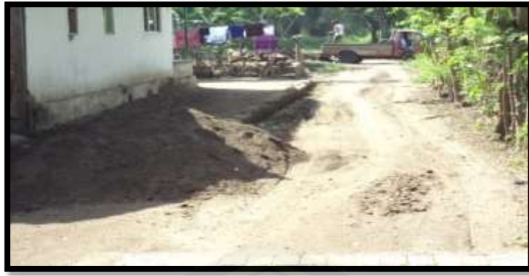
Dokumentasi Progres Dusun Aras Kidul Desa Rowogempol Pekerjaan Penambahan Jalan Paving
