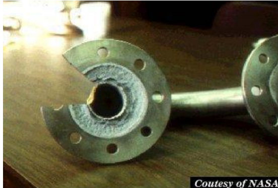
Gambar 2.3 Korosi Celah (Sumber: Utomo, 2009)
