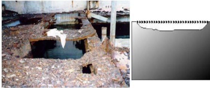
Gambar 2.5 Korosi merata pada logam. (Sumber : Studi Efektifitas Literatur Universitas Indonesia. (Online)).
