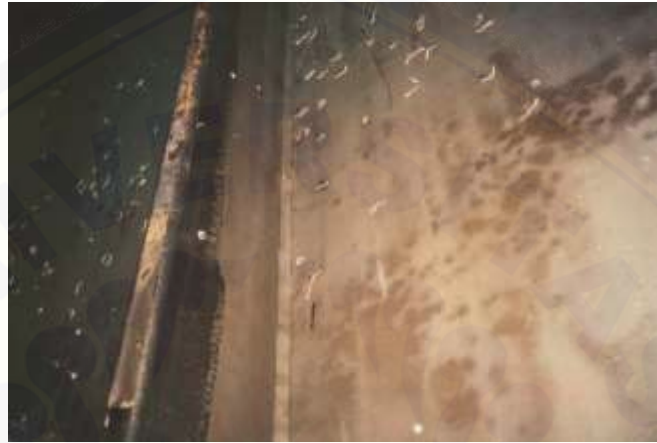
Gambar 2.8 Korosi Mikrobiologi (Utomo, 2009)
