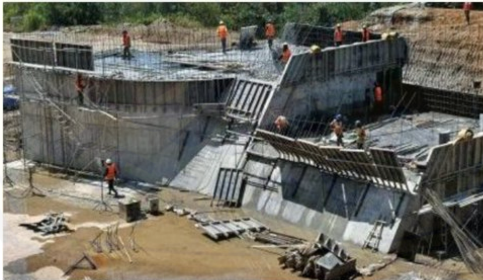
F2. Gambar Kegiatan Pembangunan
