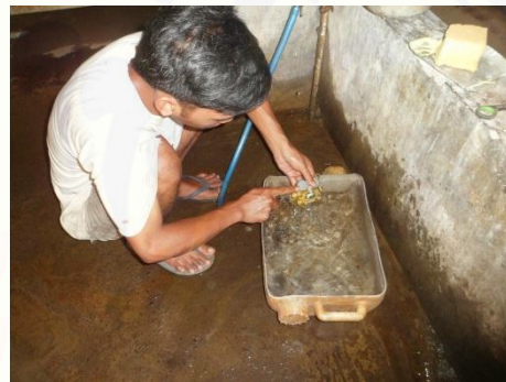
Gambar 2. Pencucian dan Penyikatan Permukaan Bahan untuk Menghilangkan Lapisan Cat
