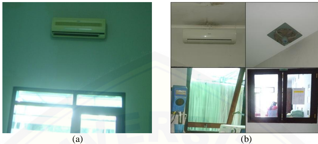
(a) Jendela di Unit CSSD yang Tertutup dan Menggunakan Ventilasi Mekanis AC ( Air Conditioner ) (b) Ventilasi Gabungan antara Ventilasi Alami dan Mekanis ( Fun dan AC) di Unit Laundry
