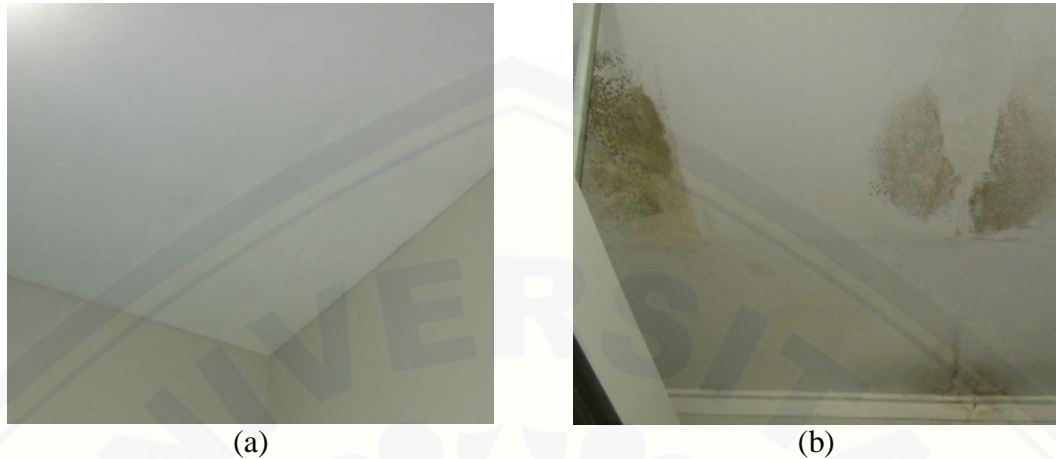
(a) Langit-Langit Unit di Unit CSSD yang Kuat dan Tidak Berlubang (b) Langit-Langit di Unit Laundry yang Kuat, Tidak Berlubang Namun Terlihat Kotor
