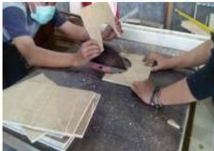
Gambar 9 : Pemotongan kayu untuk bekisting
