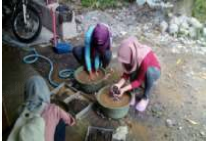
Gambar 1 : Kegiatan mencuci agregat kasar (kerikil) dan agregat halus (pasir)
