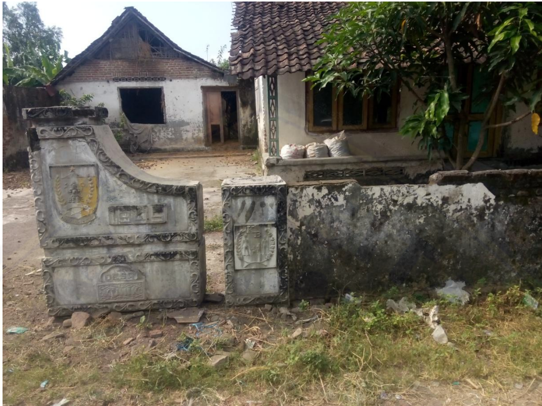
Foto rumah dari bapak Tariso yang sudah tidak terpakai lagi.
