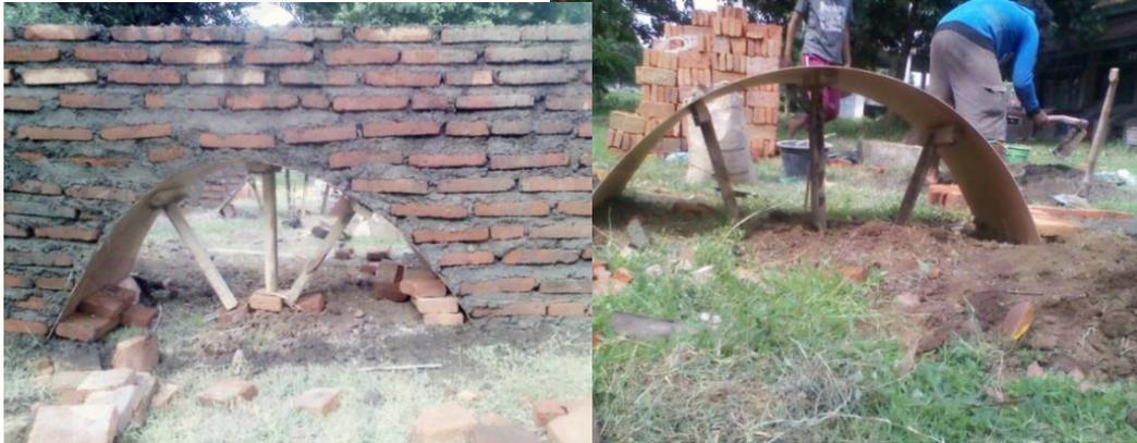
**Gambar 4.3** pabriksi pasangan batu bata dengan lengkung
