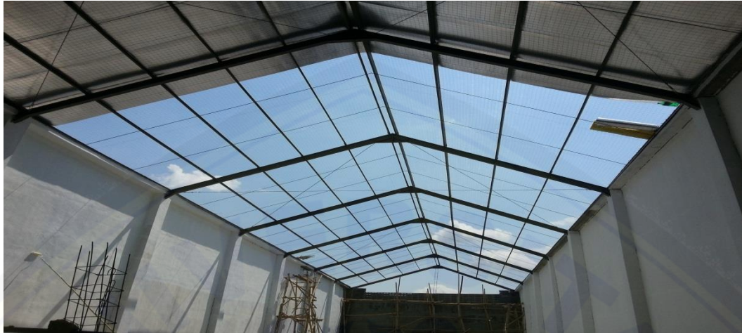
Gambar 3.1 Pembangunan gudang ajungpark
