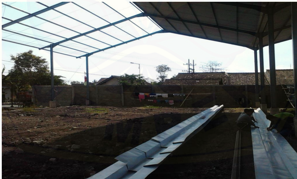
Gudang di Jalan Muhammad Thamrin dengan bentang 16,5 m
