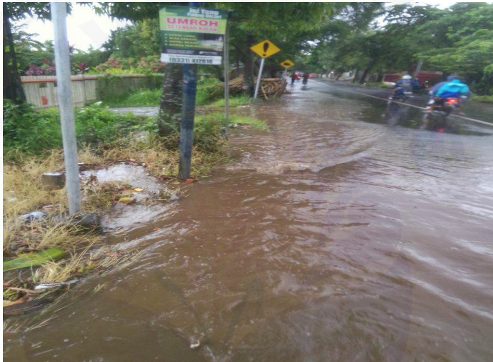
Gambar 4.1 Banjir terjadi pada pertigaan jalan Nusa Indah dikarenakan lubang inlet ke saluran drainase tertutup oleh lapak yang berada di atas saluran
