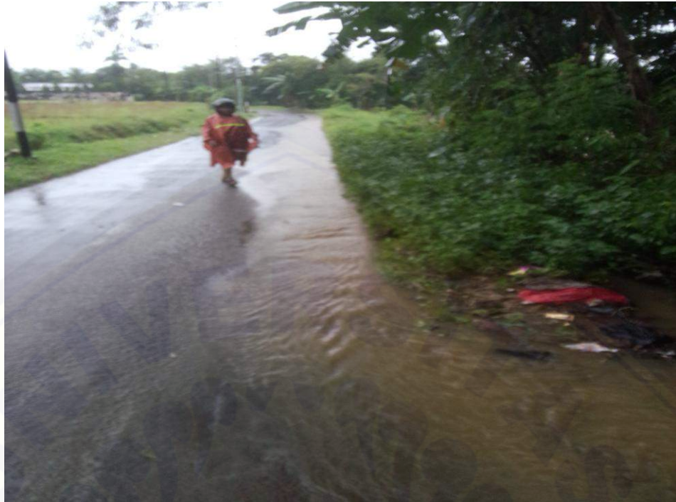
Gambar 4.2 Banjir terjadi pada jalan Merpati akibat kapasitas saluran kecil dan banyak sampah
