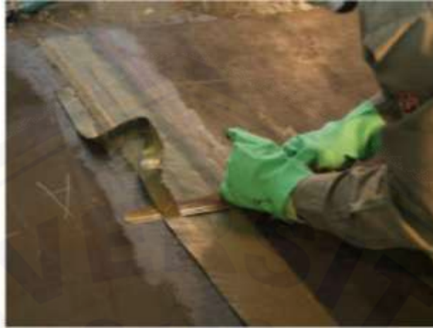
Gambar 3.15 Penutupan dengan kanisir pada bagian sambungan
