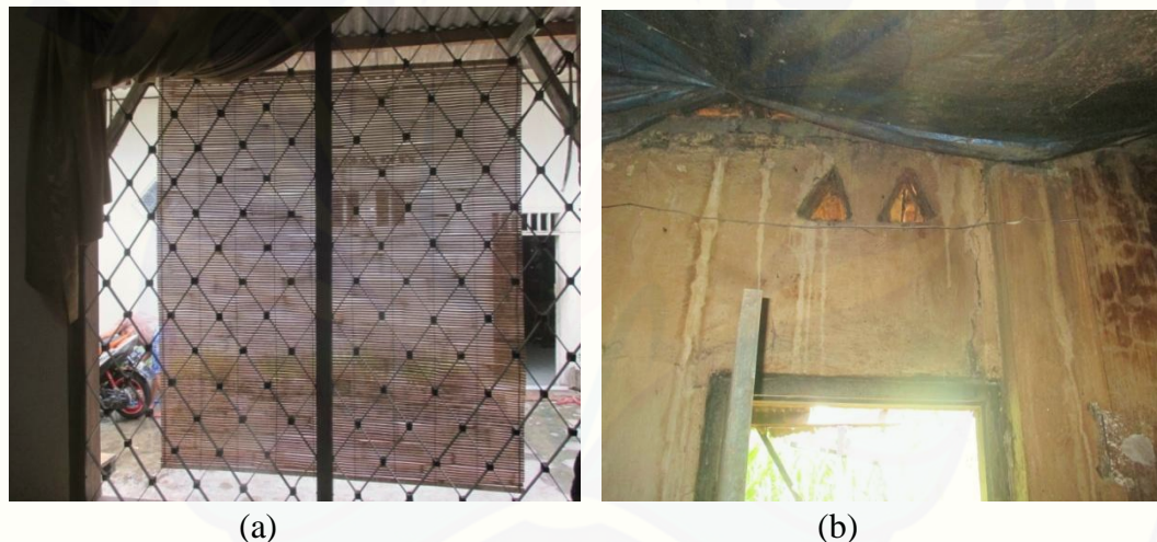
Gambar 4.14 Kebersihan Ventilasi dan Jendela (a) Ventilasi dan Jendela Dalam Kondisi Bersih, (b) Ventilasi Dalam Kondisi Kotor
