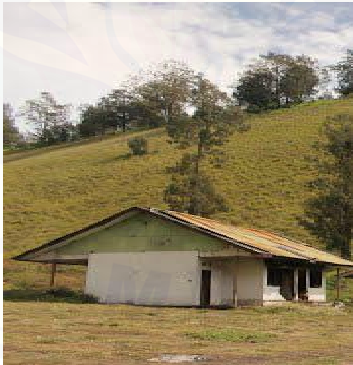
Gambar 4.4 Fasilitas MCK yang sudah tidak berfungsi lagi
