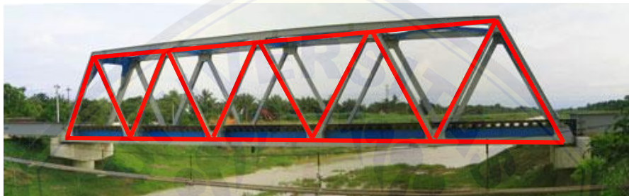
Gambar 2. Desain Kerangka Jembatan
