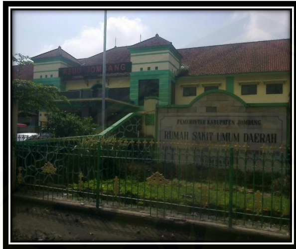
Gambar 1. Bagian Depan RSUD Kabupaten Jombang
