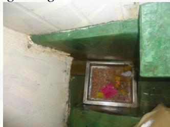
Gambar 5. Bar screen penyaring air limbah ruang proses reparasi
