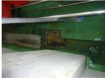
Gambar 6. Bar screen untuk menyaring air limbah
