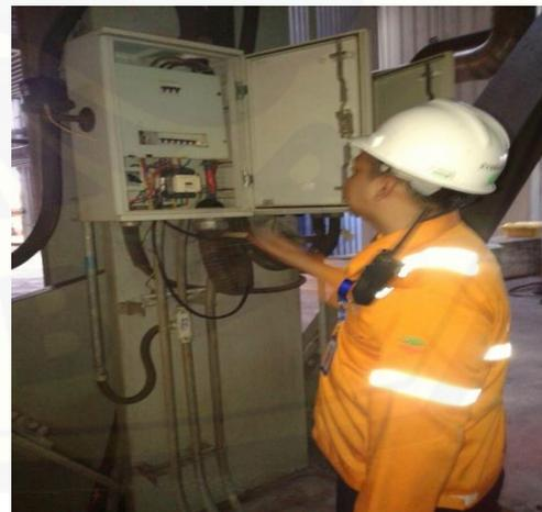
Gambar 16. Pengecekan *power* oleh operator lokal Boiler di area peralatan Fan Boiler
