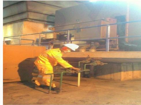
Gambar 20. Pengecekan *valve cooling* PA Fan oleh operator lokal Boiler
