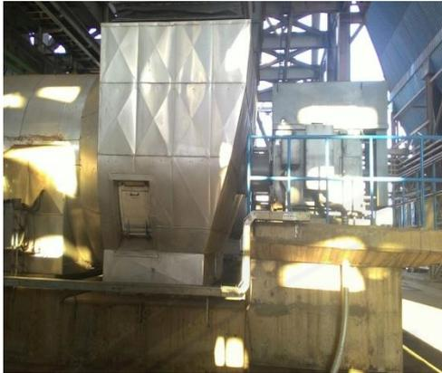
Gambar 17. Mesin ID Fan dari sisi samping kanan
