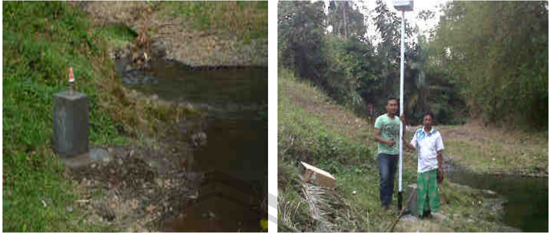
Gambar 13. Pondasi dan Tiang Sensor
