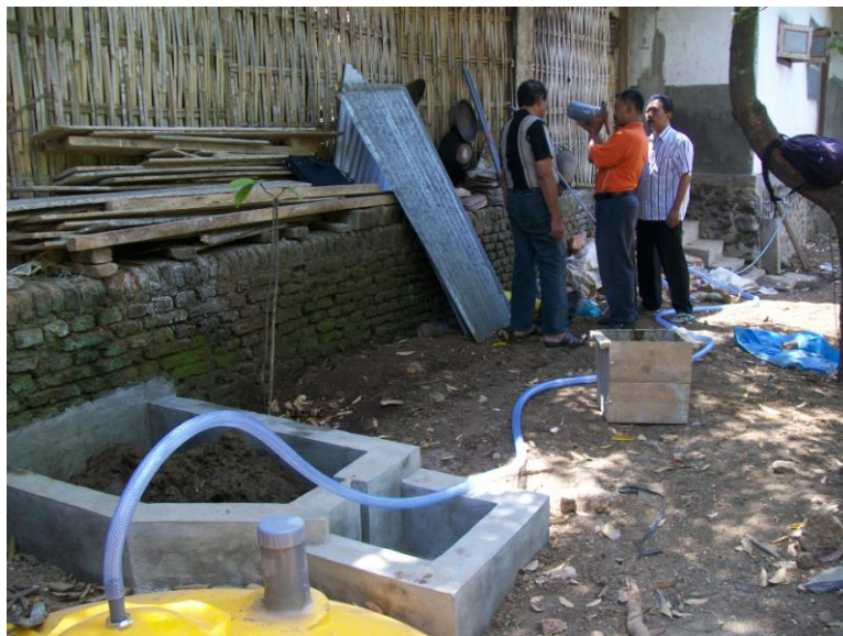
Gambar 15. Pemasangan Selang Distribusi Biogas Ke Kompor
