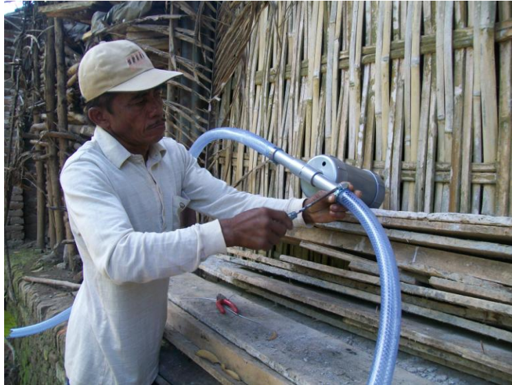
Gambar 16. Instalasi Klep Pengaman
