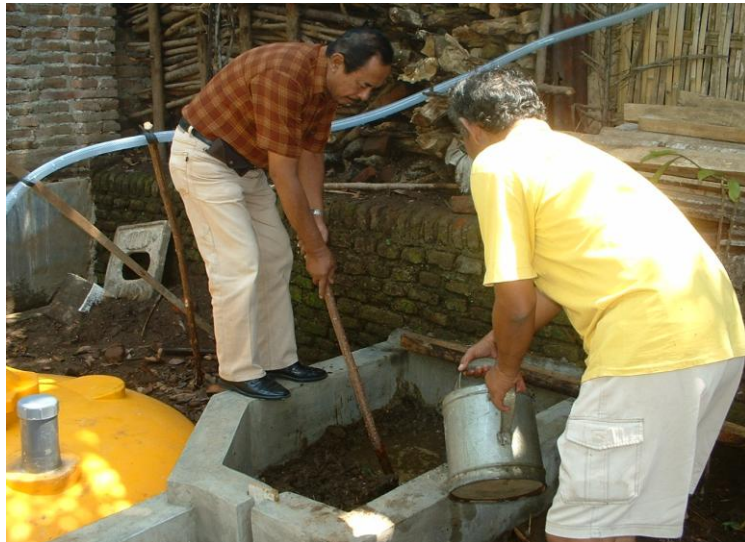
Gambar 17. Pengadukan Kotoran Sapi dan Air dengan Perbandingan 1: 1
