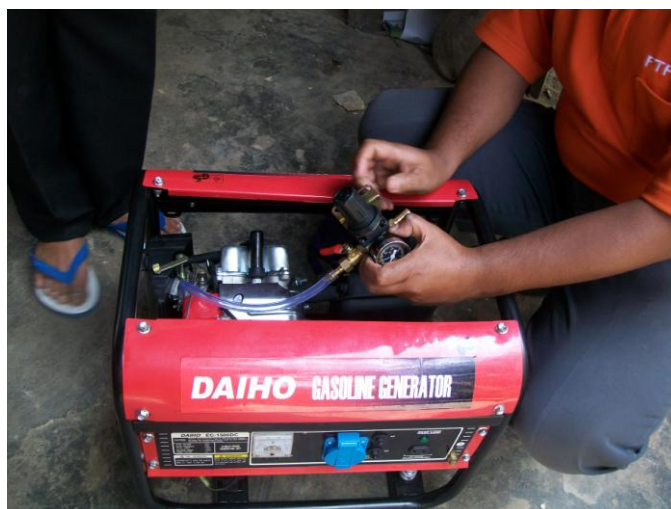
Gambar 20. Instalasi Biogas Untuk Bahan Bakar Jense
