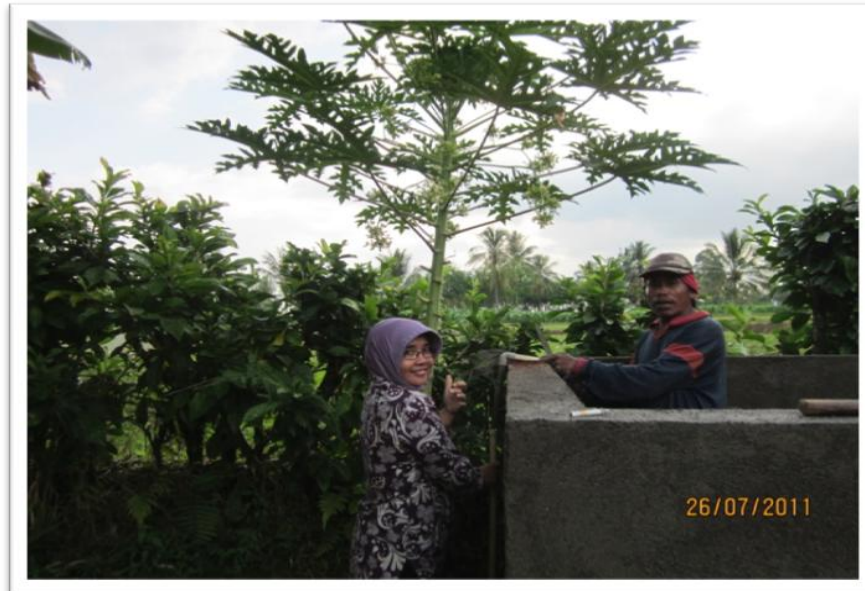
Pembangunan bak penampung air di dekat kumbung agar proses pengomposan berjalan dengan lancar dan cepat
