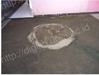
Gambar bangunan Septic Tank berupa bangunan permanen tanpa pipa ventilasi
