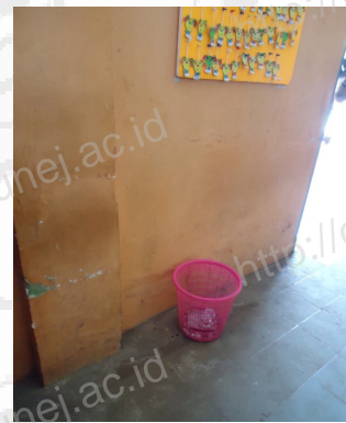
Gambar 4.27 Tempat sampah diletakkan di dalam ruangan
