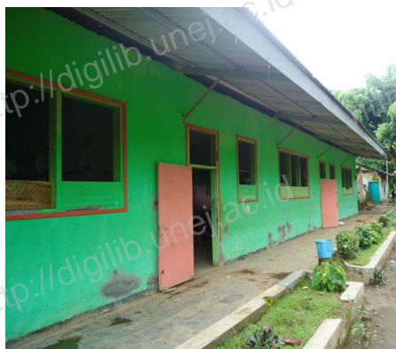
Gambar 4.4. Atap asbes
