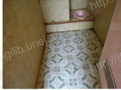
Gambar lantai kamar mandi dan jamban tidak licin serta dinding kamar mandi kedap air dan mudah dibersihkan
