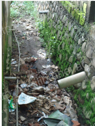
Gambar saluran pembuangan air limbah berupa lubang yang langsung mengarah ke tanah
