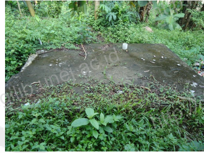
Gambar tutup Septic Tank terbuat dari bahan kedap air dan terdapat pipa ventilasi
