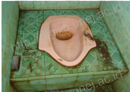
Gambar kloset dengan saluran berbentuk leher angsa
