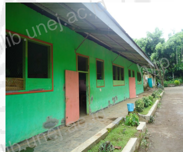
Gambar atap asbes
