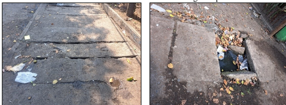
b. Kondisi saluran drainase di luar bangunan pasar
