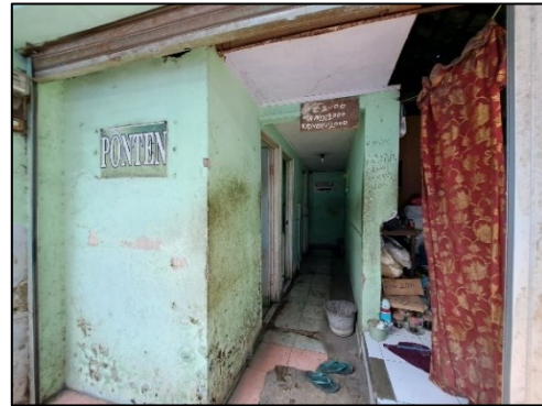
b. Toilet bagian samping pasar
