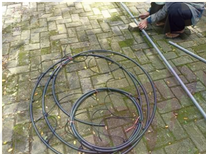
Pemotongan Pipa PVC dan LDPE
