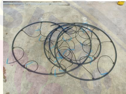
Pemasangan PCJ dan Emmitter
