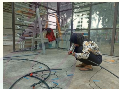
Pemasangan Stop Kran
