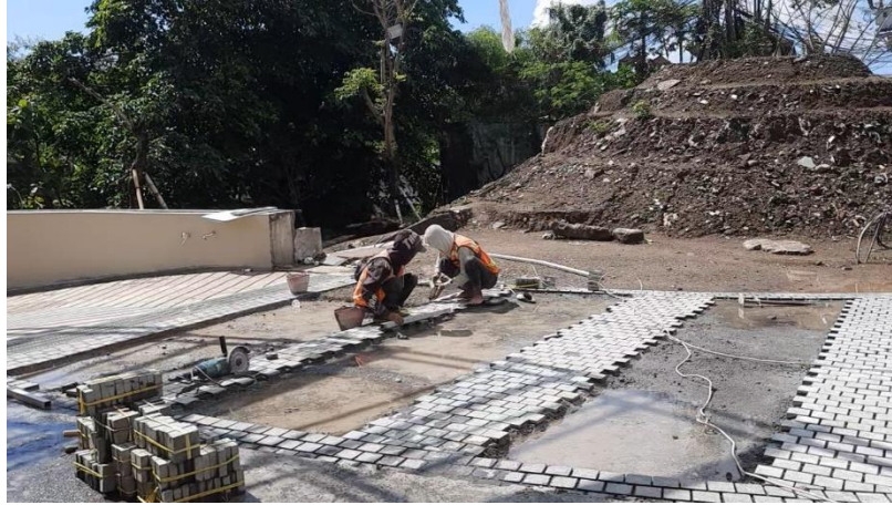
Gambar 4.8 Pemasangan Cobble Stone Dropoff Ukuran (10x10)
