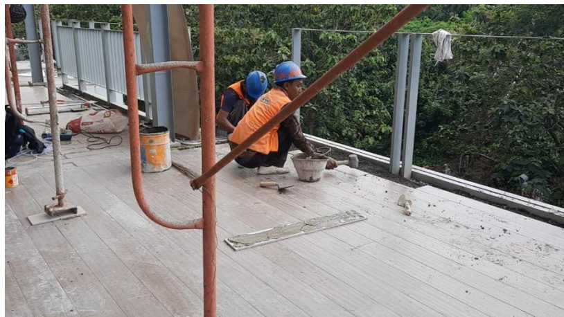
Gambar 4.2 Proses pemasangan Granit Balkon LT GF Ukuran (15x90)
