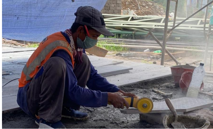
Gambar 4.10 Pemasangan Granit Dropoff Ukuran (30x60) Dan (15x60)
