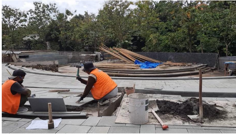
Gambar 4.6 Pemasangan andesit amphiteaher ukuran (60x60)
