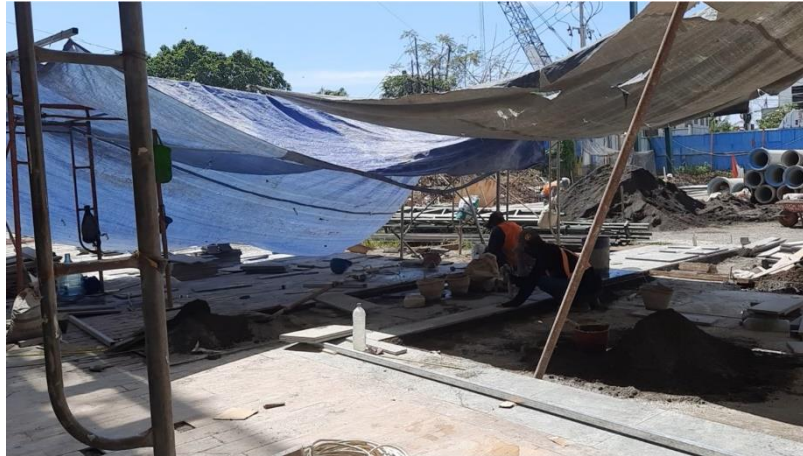
Gambar 4.12 Pemasangan Granit Dropoff Ukuran (15x60)
