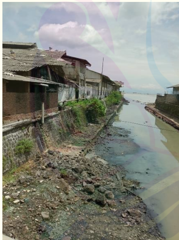
Gambar 3. Sungai Tratas yang tepat di sebelah Pabrik Pasifik
