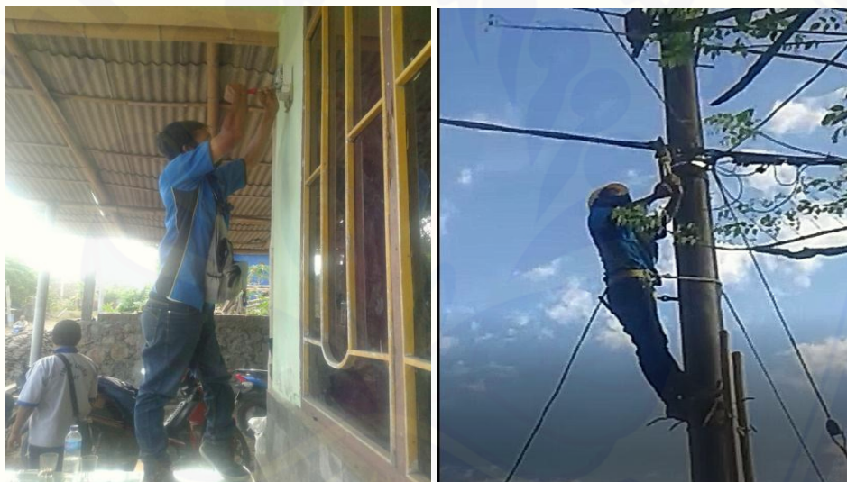
Gambar 7. Proses Penambahan Daya Listrik Di Rumah Mitra Sebagai Sumber Listrik Dalam Kegiatan Produksi Yang Dilakukan Oleh Mitra (Sumber: Dokumentasi Lapangan, 2020)
