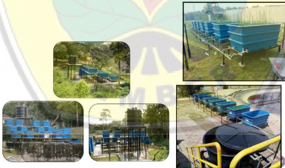
Gambar 2. Teknologi pengolahan air limbah menggunakan tumbuhan (Dokumentasi pribadi Prof. Ir. Dr. Siti Rozaimah Sheikh Abdullah)
