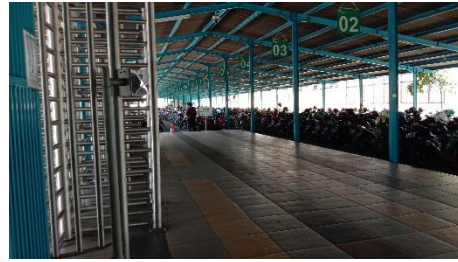
Gambar 10 Gate pedestrian yang berada pada area yang terpisah dengan gate bagi kendaraan (gambar diambil pada 17 Maret 2020)
