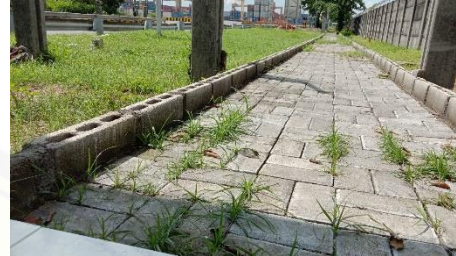
Gambar 2 Raised kerbs pada jalur pedestrian (gambar diambil pada 17 Maret 2020)
