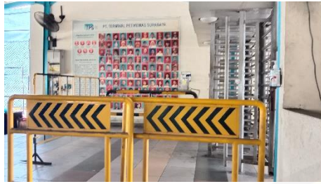
Gambar 9 Pagar barrier pada gate in dan gate out pedestrian (gambar diambil pada 17 Maret 2020)
