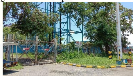
Gambar 12 Pagar pembatas dan gerbang serta rambu larangan masuk bagi pekerja dan pedestrian yang tidak berkepentingan (gambar diambil pada 17 Maret 2020)
