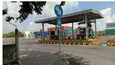
Gambar 4 Rambu titik penyeberangan yang terpasang dan zebra cross yang memudar (gambar diambil pada 17 Maret 2020)
