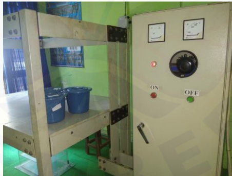
Gambar 3.2 Current Transformer (Sumber: Dokumen pribadi, 2020)
