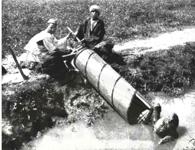
Gambar 2.1 Pompa (*Archimedes Screw*) (sumber : Rorres, 2000)
