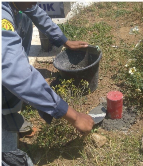
Gambar 23 Pemasangan Patok BM
