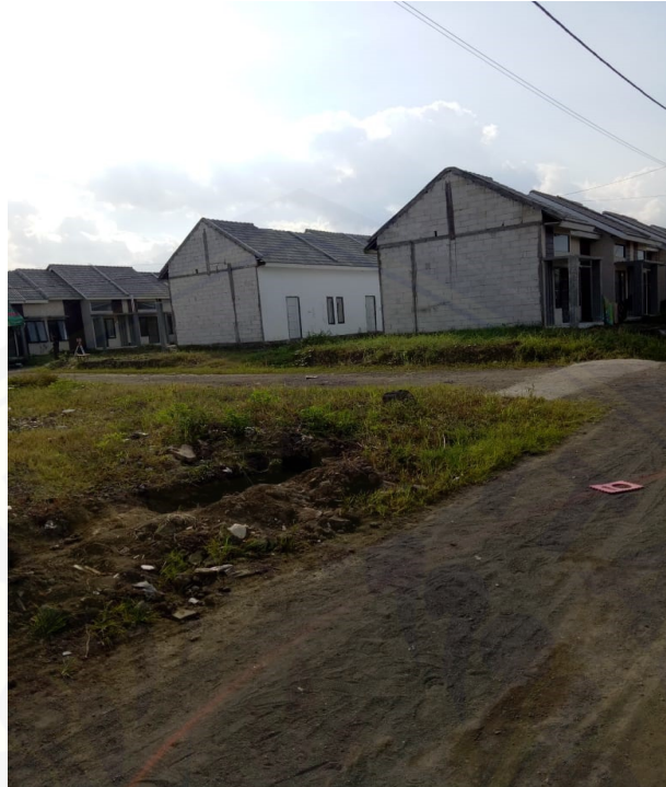
Gambar 20 Lokasi Pengukuran bangunan
