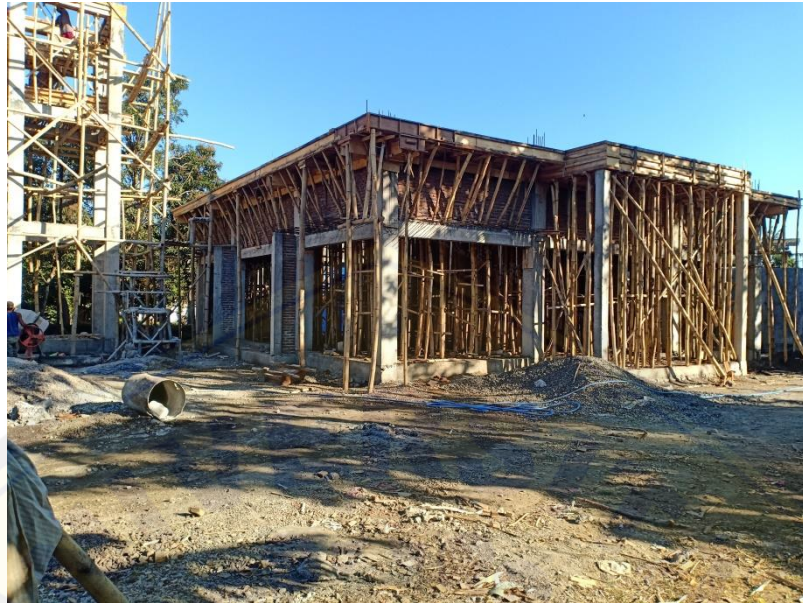
Gambar 3 : Pembangunan Masjid PMMP (baru) Sumber : dokumentasi Pribadi
