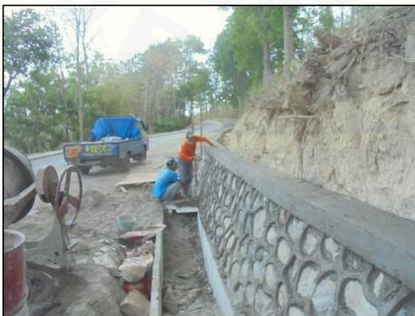
Pekerjaan Pasangan Batu di Sta berbeda
