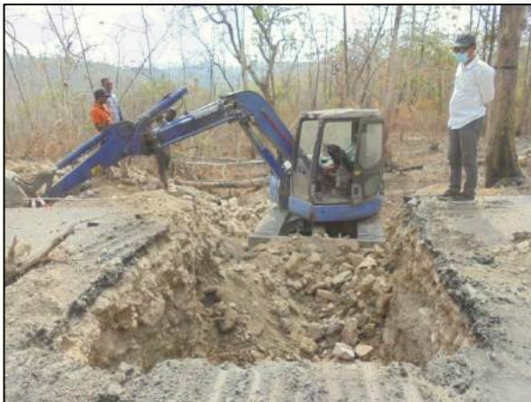
Pekerjaan Persiapan Drainase
