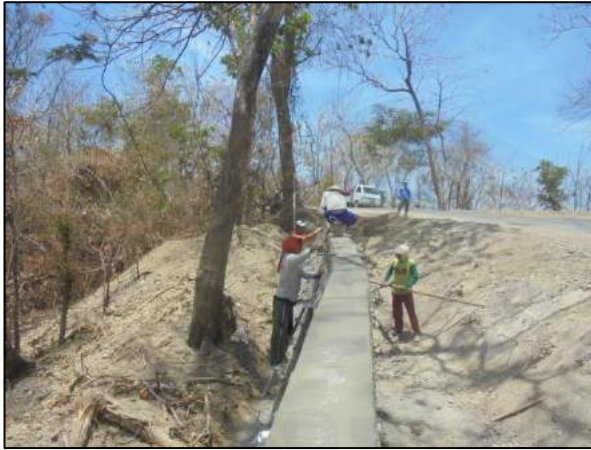
Pekerjaan Pasangan Batu
