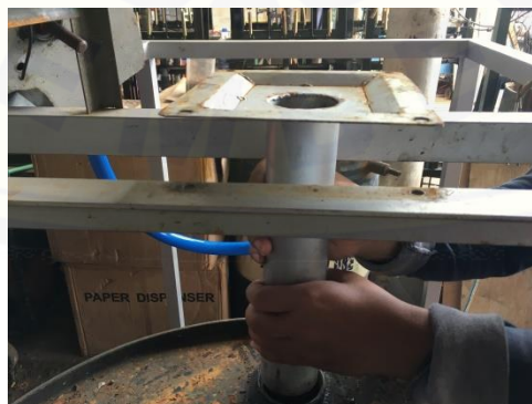
Gambar C.3 Pemasangan pipa antara rumah turbin dan tangki air
