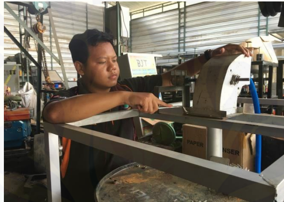
Gambar C.5 Pemasangan rumah turbin
