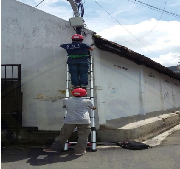
Gambar 3 Proses penyambungan di luar ruangan
