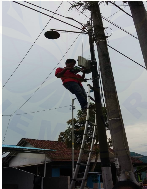
Gambar 4 Proses penyambungan di luar ruangan
