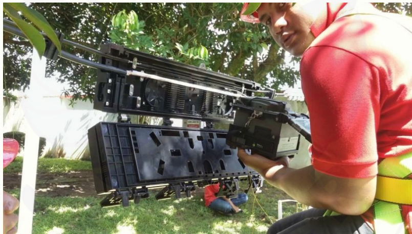
Gambar 2 Proses penyambungan di luar ruangan
