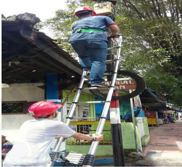
Gambar 5 Proses penyambungan di luar ruangan
