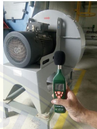
Pengukuran kebisingan blower pada boiler
