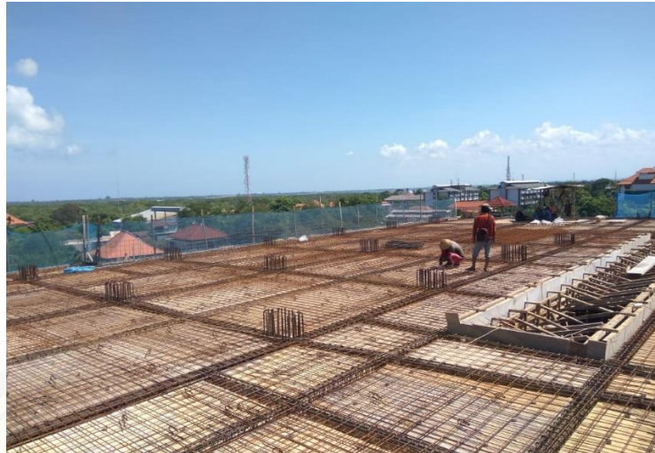
Gambar D.3 Penggunaan Safety Net di Proyek
