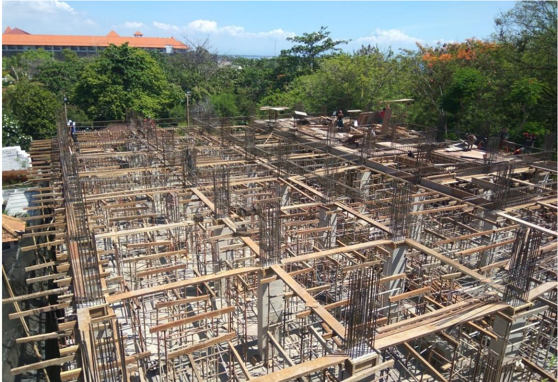
Gambar D.1 Kondisi Pembangunan Proyek Hotel Bali Tropic
