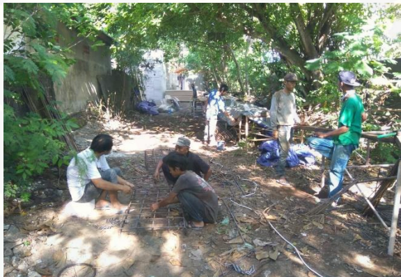
Gambar D.4 Pemanfaatan Sisa Potongan Besi Tulangan (<1 meter)
