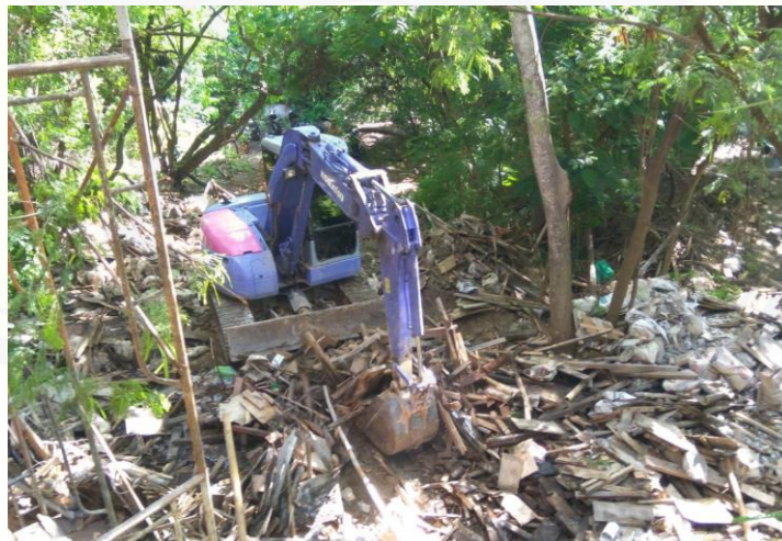
Gambar D.5 Penggunaan Bekas Bobokan Bangunan Untuk Timbunan
